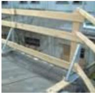
Trattasi dell'installazione di parapetti per essere utilizzati come sostegni di protezione provvisori contro la caduta dall'alto durante attività di costruzione, riparazione o ristrutturazione, permettendo di lavorare su balconi, terrazze, scale e tetti (*pendenza non superiore a 30°*) in calcestruzzo di edifici civili ed industriali. Il montaggio dei parapetti provvisori (*montanti verticali e traverse orizzontali*) viene eseguito con l'ausilio di autocestello.
